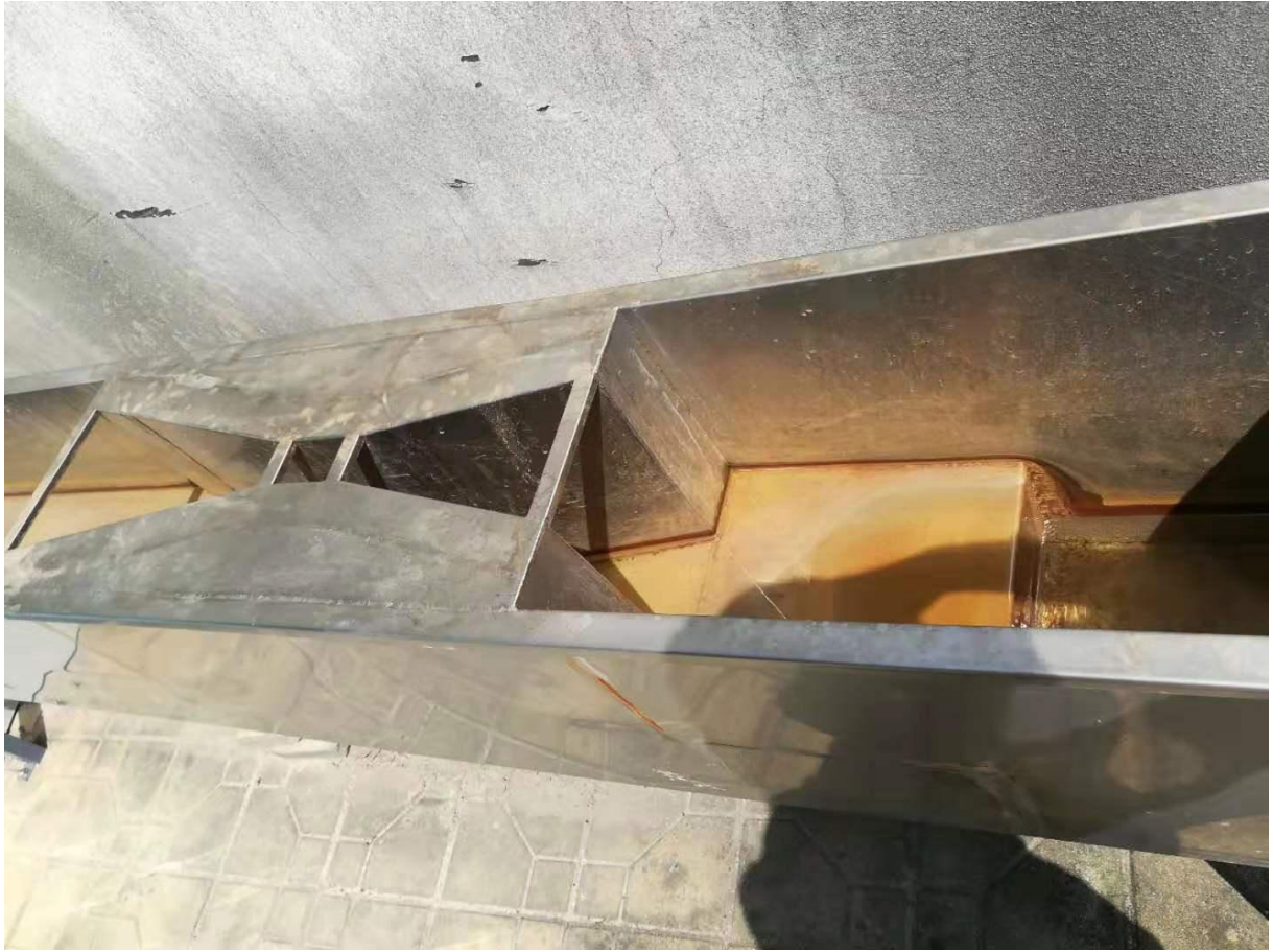
附件七 废水排放口
